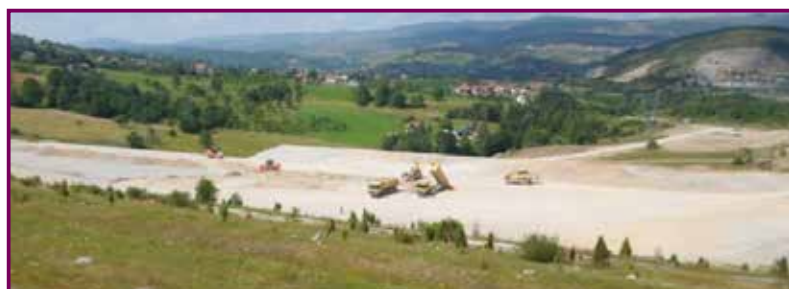
Izrada balasta na brani Maljevac (izvođenje radova)
