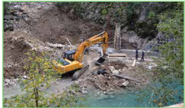
Detalj sa radova na sređivanju izlaznog kanala
