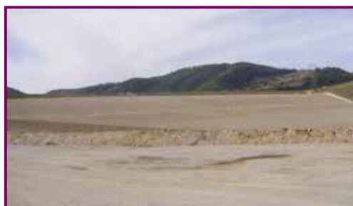
Pogled na balast na brani Maljevac (završeno izvođenje balasta septembar 2015.)
