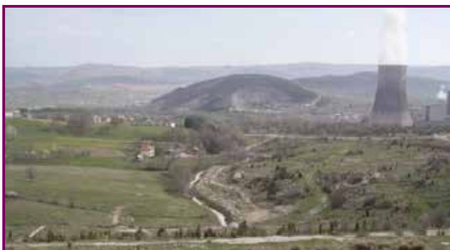
Nizvodno od brane Maljevac (postojeće stanje – prije početka radova)
