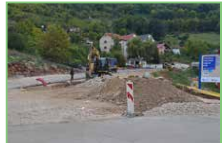
Radovi na raskrsnici u Plužinama
