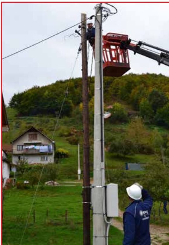
Monteri Rade Mihailović (na stubu) i Veselin Veličković demontiraju staru NN mrežu „Rasovo“, jer je u okviru AMM projekta izgrađena nova na AB stubovima.
