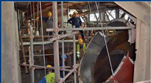
Iz drugog ugla: Remont oduzimne glave na kotlu
