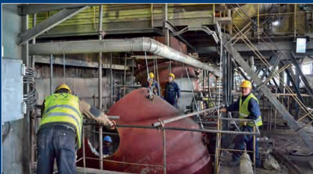
Remont oduzimne glave na kotlu
