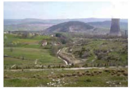
Nizvodno od brane Maljevac (postojeće stanje - prije početka radova)
