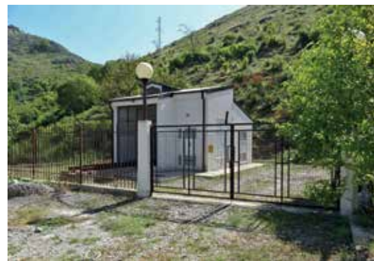
NOVA TS VRANJINA 35/10/0,4KV
