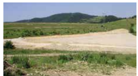
Pogled na balast na brani Maljevac (izvođenje radova)
