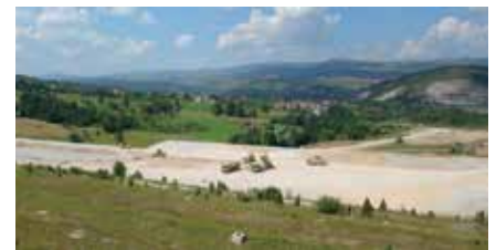
Izrada balasta na brani Maljevac (izvođenje radova)
