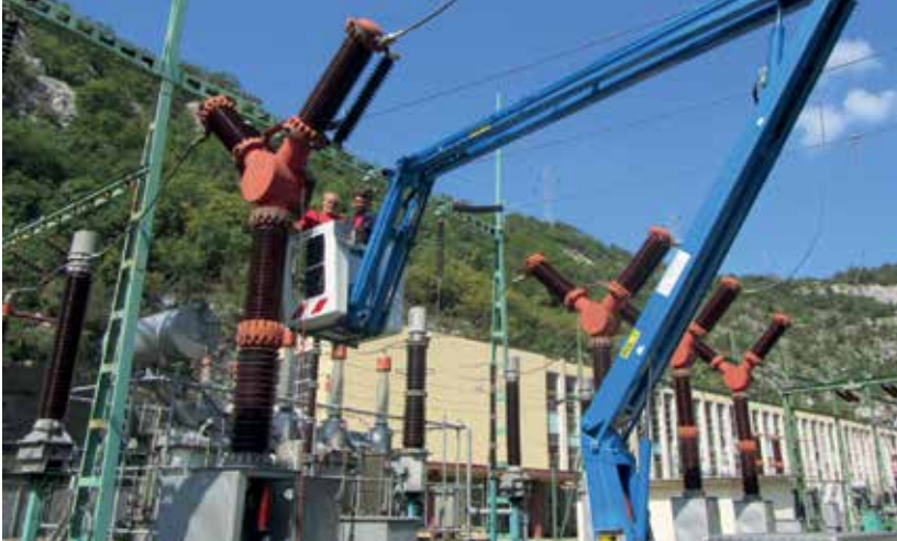
REMONT VISOKONAPONSKOG PREKIDAČA 220 KV
