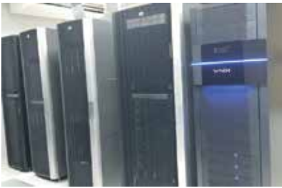
Sl.1. - Dio hardware-ske infrastrukture u data centru u Nikšiću (krajnje desno EMC VNX 5600)
