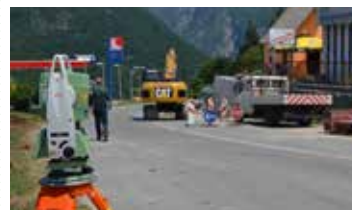
Detalj sa radova na raskrsnici
