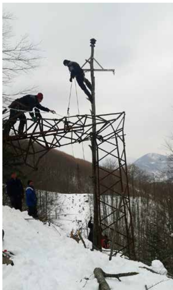
Improvizacija: Privremena sanacija stuba
