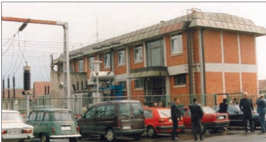
ТС 110/10 kV Подгорица 2
