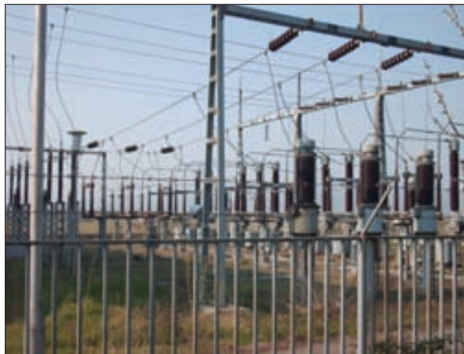
ТС 110/10 kV Подгорица 3
