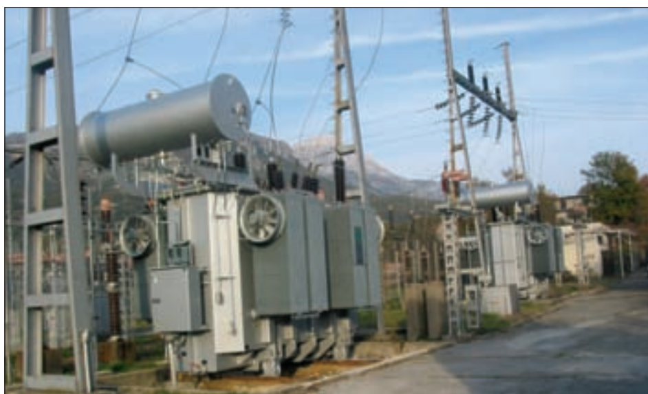
ТС 110/35 kV "Поду" - Херцег Нови
