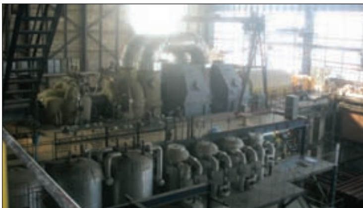
Детаљ из Машинске хале
