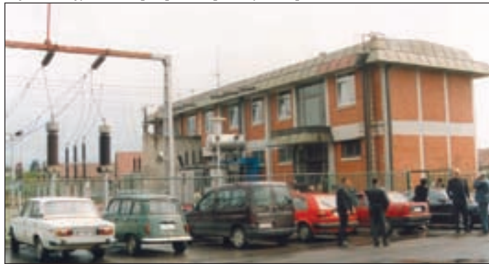
ТС 110/10 kV Подгорица 3
