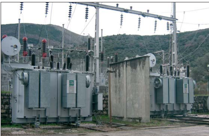
Нови трансформатори 110/35 kV (2 x 40 MVA)
