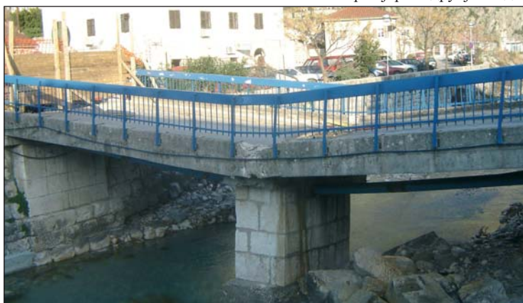
Због пукотине на мосту отежан приступ ЕД Котор
