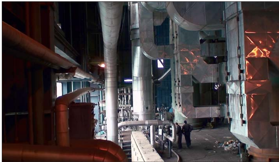
Детаљ из ТЕ у току ремонта
