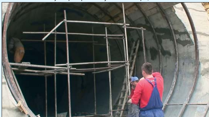
Излаз тунела "Плијеш"
