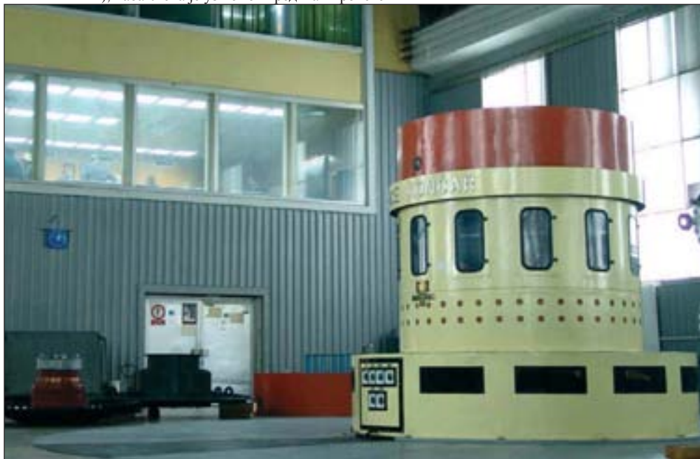
Детаљ из Машинске хале ХЕ Пива
