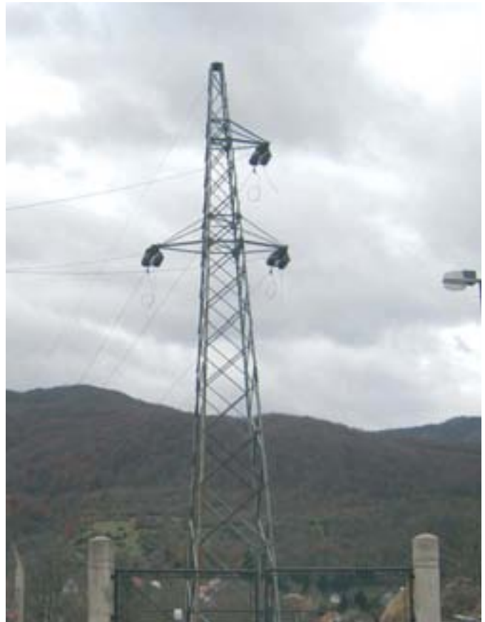
Стуб реконструисаног ДВ 35 kV Дријенак - Манстир Морача
