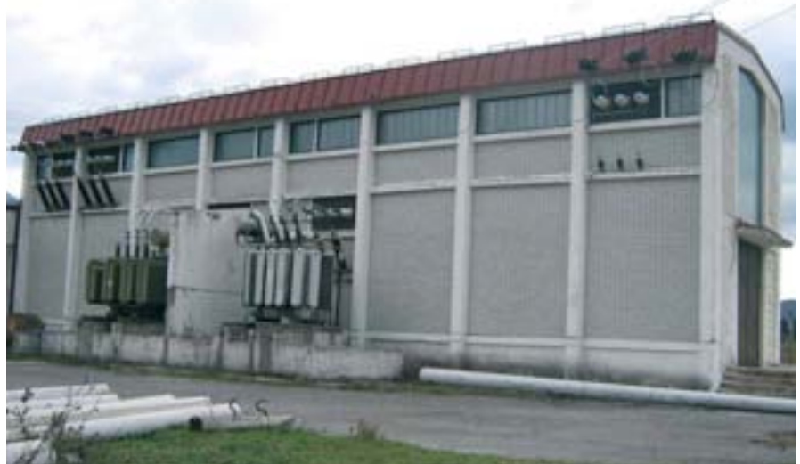
ТС 35/10 kV Дријенак
