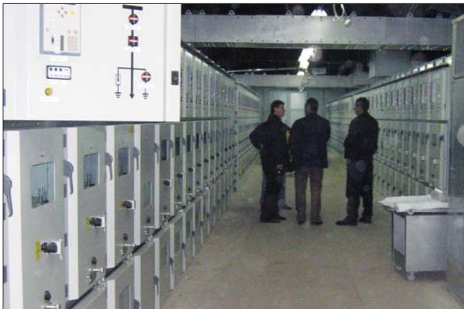
Ново постројење 6 kV
