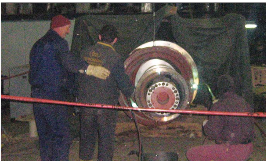
Нови ротор генератора
