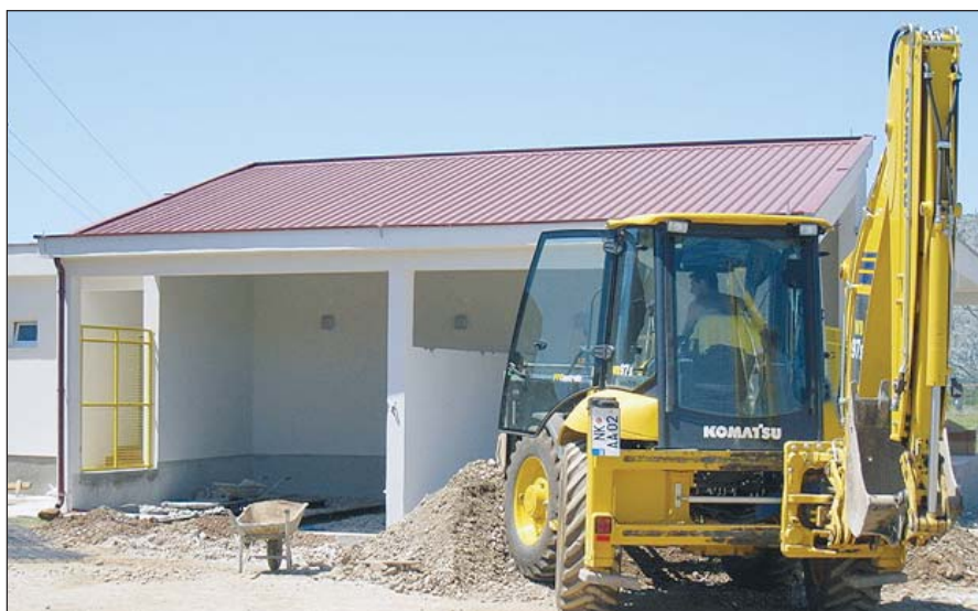
ТС Горња Зета у изградњи
