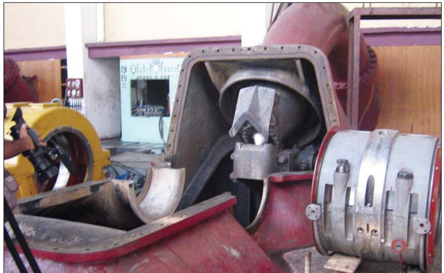
Ремонт VII агрегата
