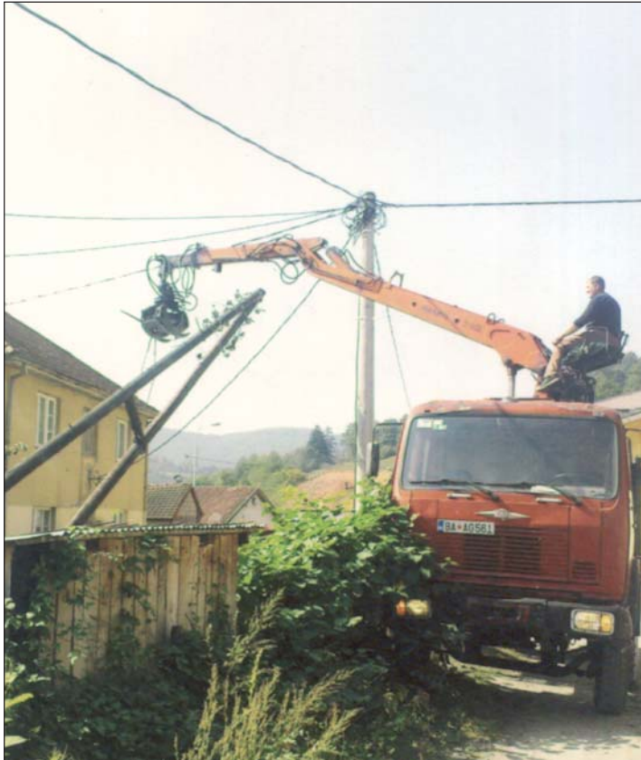
Реконструкција НН мреже у Петњици
