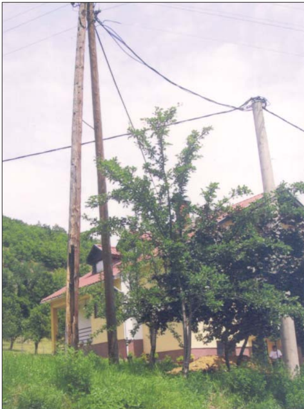
Замјена трулог "А" стуба новим бетонским у трафо реону Долац - Липери
