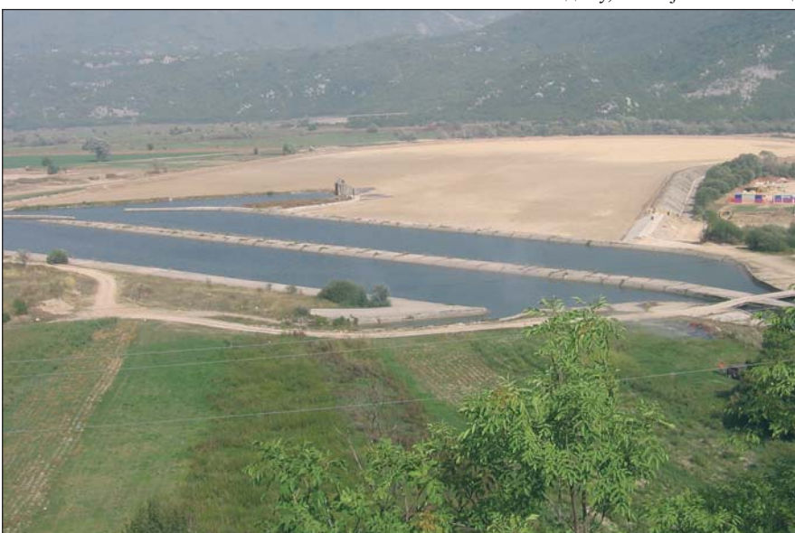
Компензациони базен код улазне грађевине ХЕ Перућица
