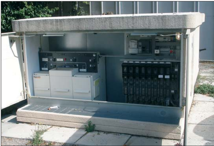
ТС 10/0,4 kV Расадник
