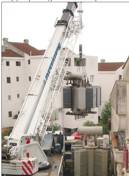
Замјена трансформатора 8 MVA у ТС 35/10 kV Дубовица
