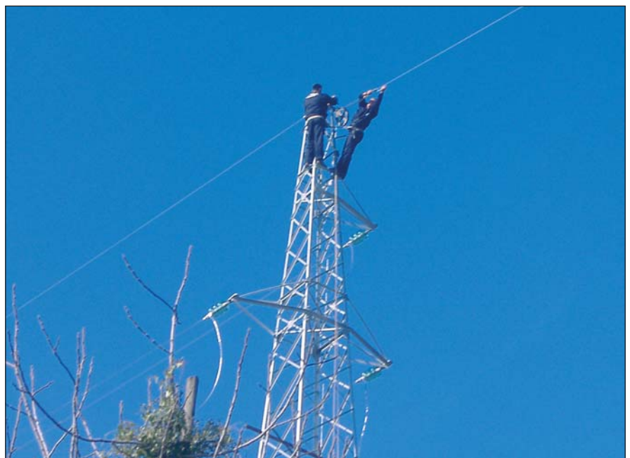
Монтери Електроградње на ДВ стубу
