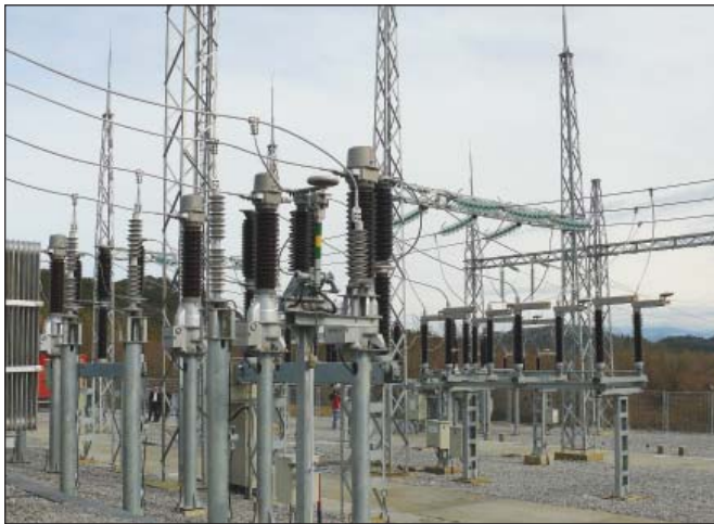
ТС 110/35 kV Вирпазар – 110 kV постројење
