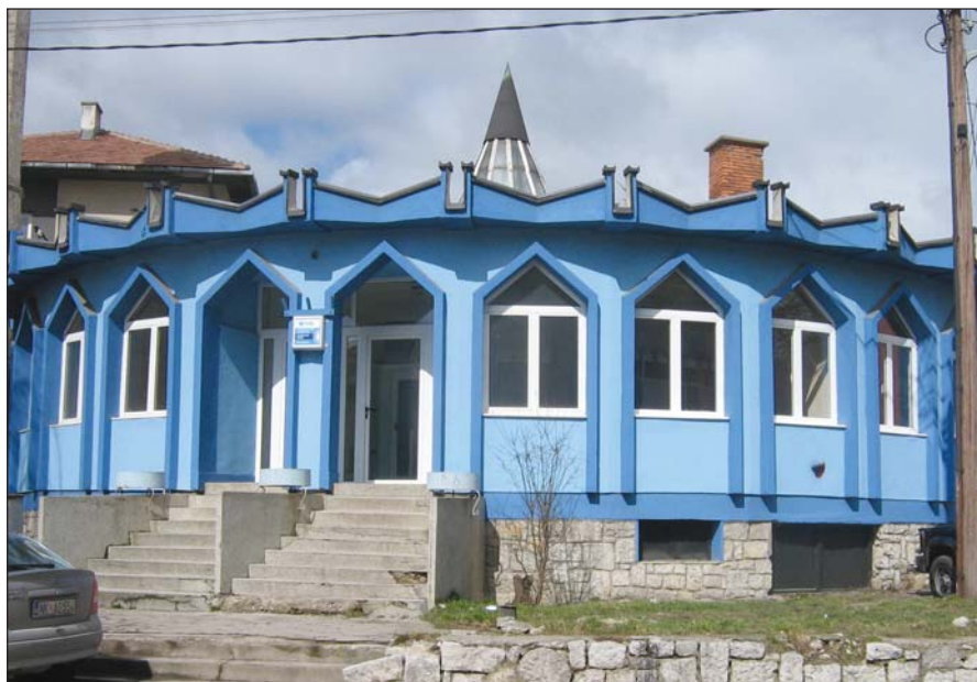
Зграда Снабдијевања Пљевља
