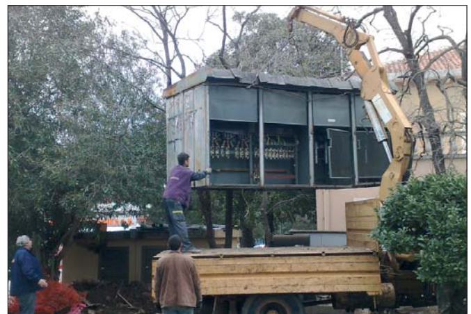
Демонтажа старе БТС код "Зета филма"
