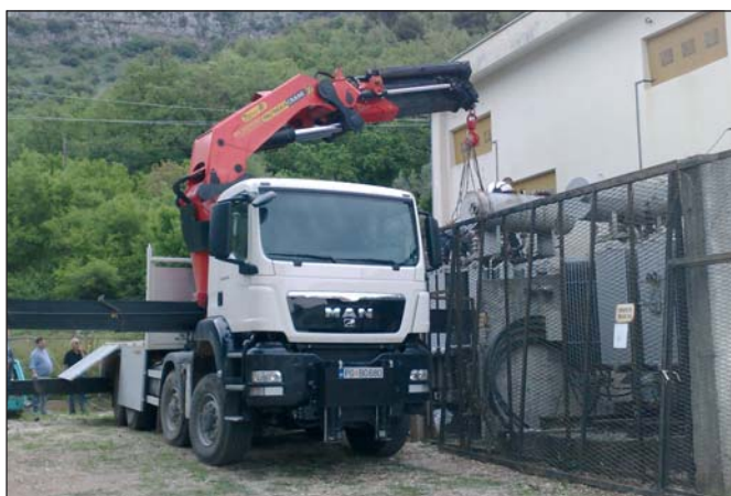
Замјена трансформатора 35/10 kV Лази
