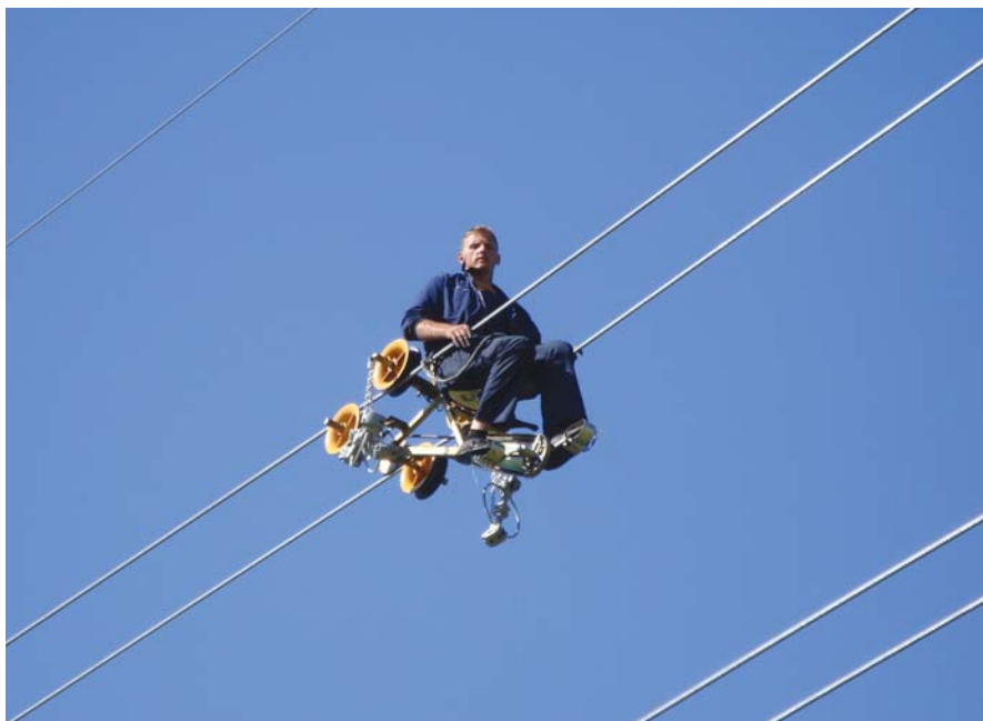
Upotreba tzv. bicikla za postavljanje odstoynika na užadima
