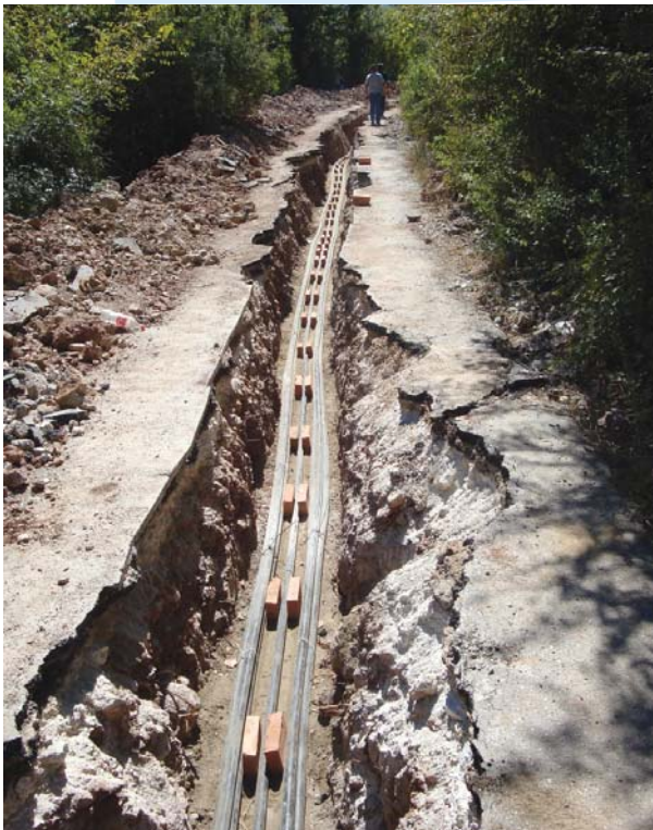
Polaganje 35 kV kablova
